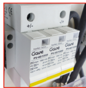
Protector de sobretensiones Conexión superior de las fases e inferior de la tierra. Indicación visual de final de vida
