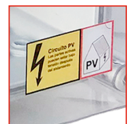
Señalización de seguridad Adhesivos conforme los requisitos del apartado 514 de la norma para la seguridad de las personas
